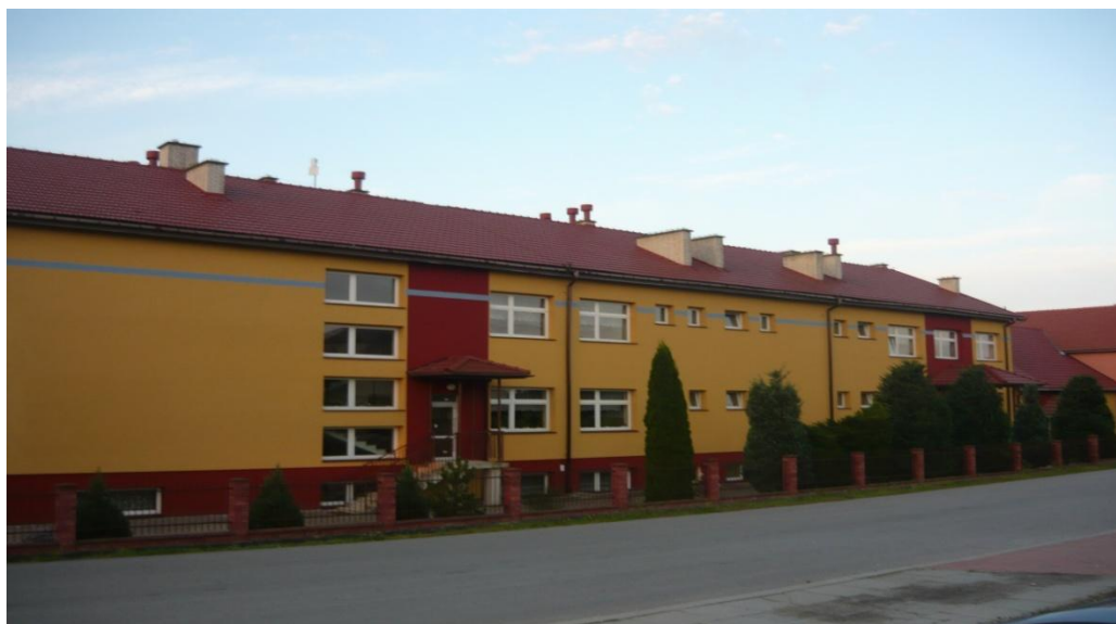
Budynek Zespołu Szkół im. Jana Pawła II Staszkówce – październik 2011r.
