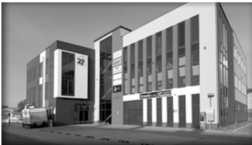
Domu na Polnej w Gorlicach już nie ma na jego miejscu stanął taki budynek, 2024 r.
