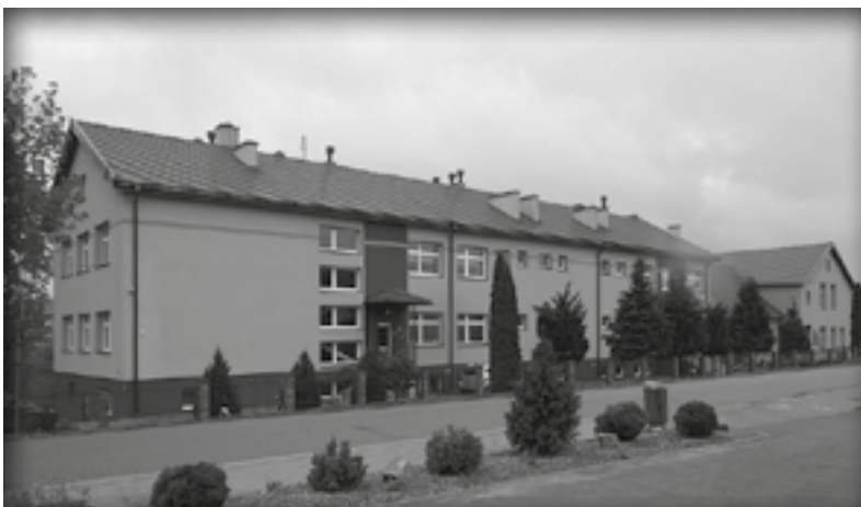
Szkoła w Staszówce, stan obecny (2024 r.). Budynek zastłonięty drzewami to dawna szkoła w której uczyli Wojciech i Katarzyna Szatko, po prawej część zbudowana w latach 2000.
